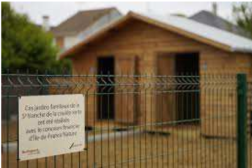
Abris de jardin de 9 m 2 avec récupérateur d'eau raccordé à la gouttière. Parcelle entre 80 et 120 m 2
