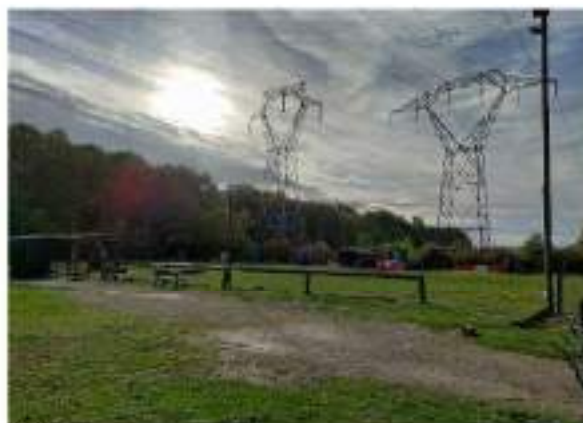
2 Ligne à haute tension au-dessus de L'Arrière.
