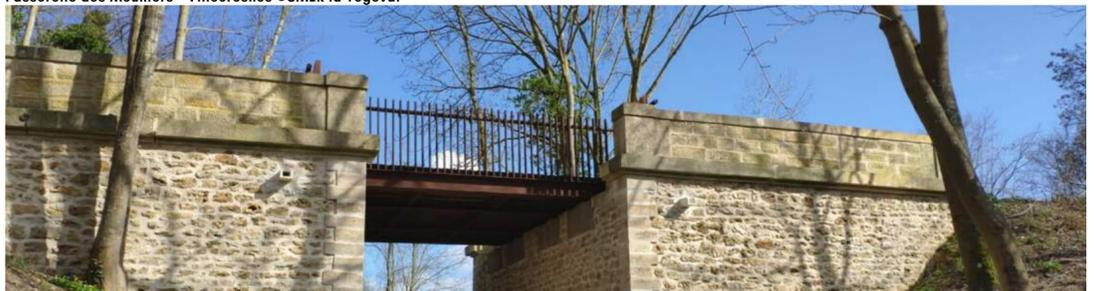
La passerelle des Meuniers remplace aujourd'hui l'ouvrage ferré démolie par la Sncf lorsque la ligne Paris-Bastille / Verneuil-l'Étang a été désaffectée. L'objectif était de nettoyer et de réparer les maçonneries très bien conservées puis d'y installer un tablier métallique avec un platelage en bois. L'utilisation d'acier Corten autopatinable permet de respecter l'esprit de l'ouvrage historique et de s'intégrer dans le paysage boisé tout en garantissant un besoin d'entretien faible.
