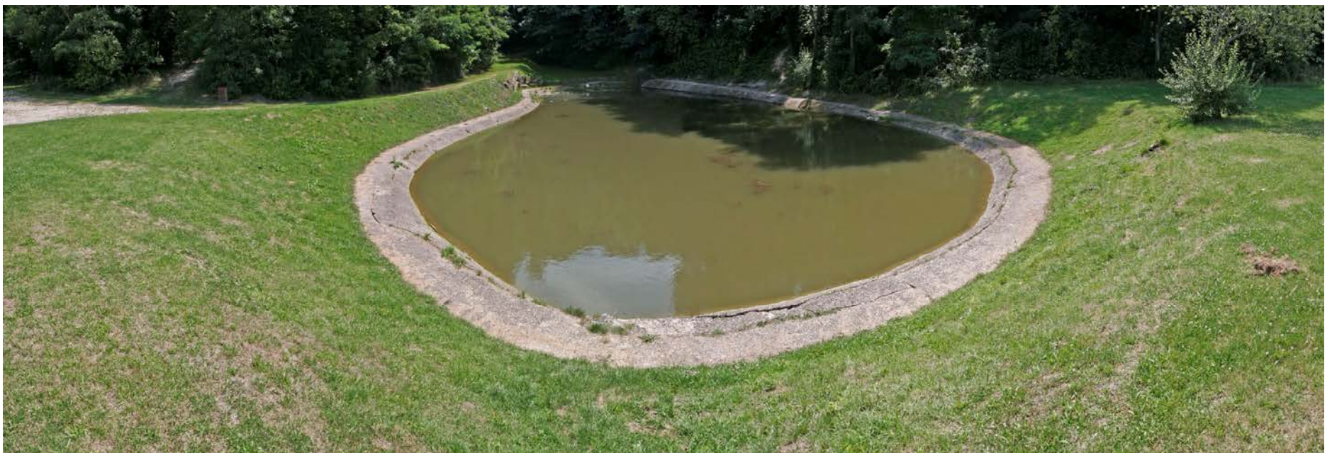
Vue sur le bassin sud, 01/08/07
