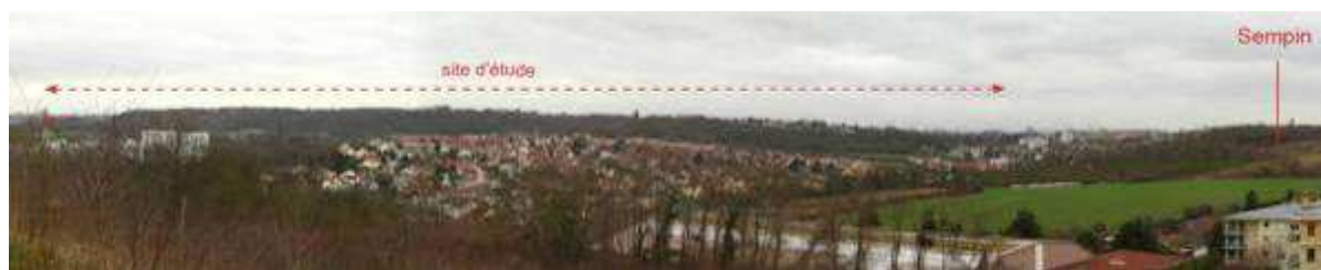
Figure 42 : Vue du site depuis la Montagne de Chelles : lecture de la liaison entre côte de Beauzet et Sempin
