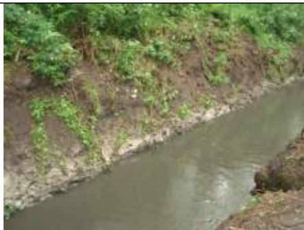
Photo après curage du ru des Cerceaux
