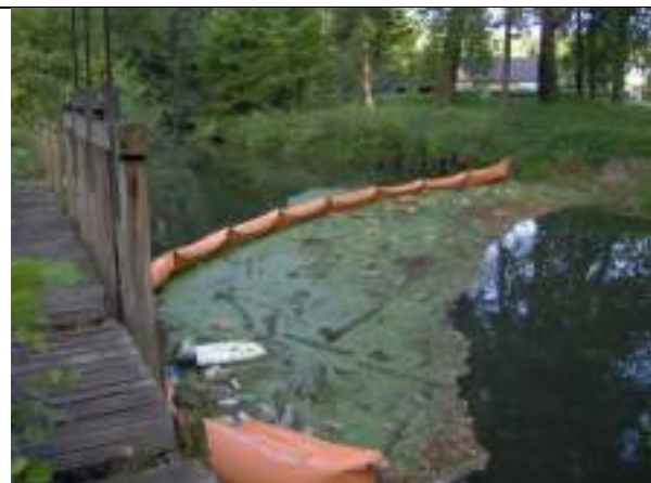
Photo du barrage du marais de Gommecourt étude CIAE, MO-2006
